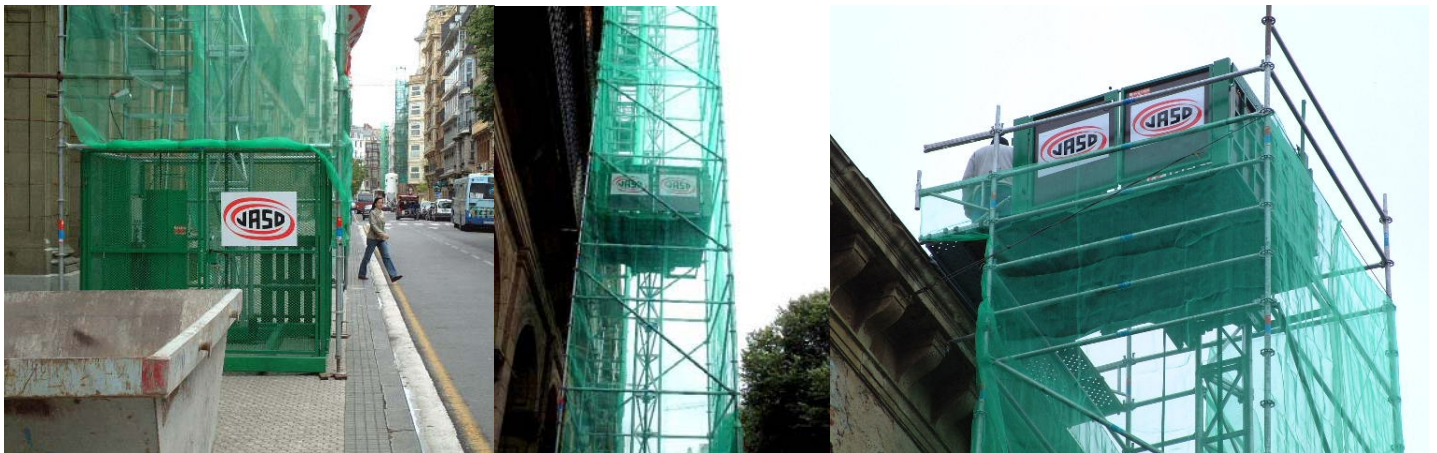
Montacargas para obra / Material Hoist Rehabilitación / Rehabilitation
